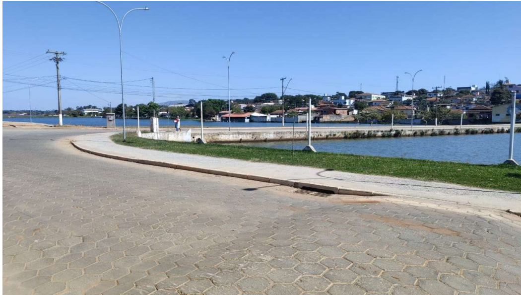
Foto 03: Orla da Avenida Copa Cabana - Local da instalação do guarda corpo.
