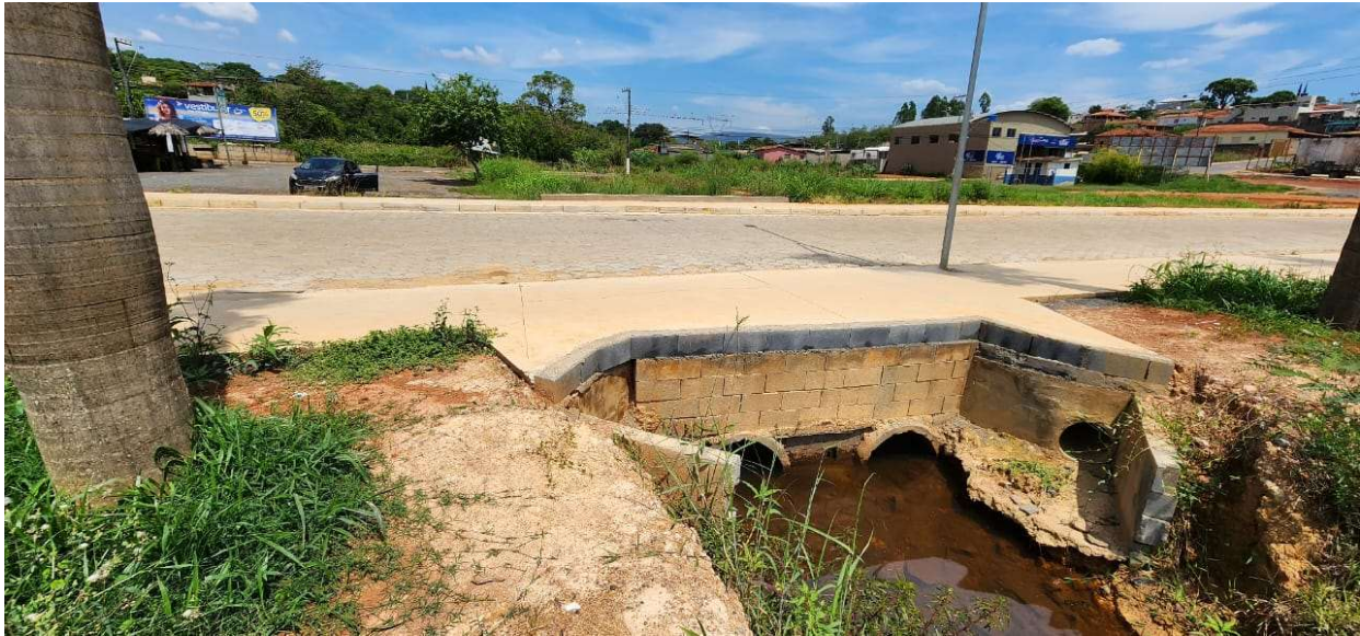
Foto 07: Avenida Copa Cabana trecho paralelo a Rua Olinto Fonseca - Local da instalação do guarda corpo.
