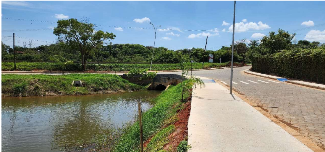
Foto 05: Avenida Copa Cabana com Av. Dois do Bairro Peixe Vivo - Local da instalação do guarda corpo.
