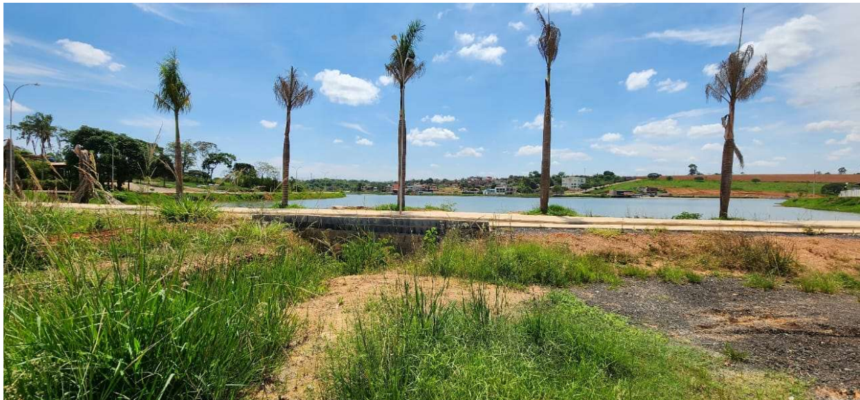
Foto 08: Avenida Copa Cabana trecho paralelo a Rua Olinto Fonseca - Local da instalação do guarda corpo.
