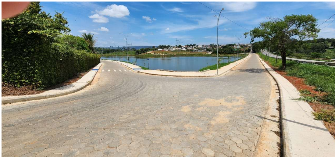
Foto 06: Avenida Copa Cabana com Av. Dois do Bairro Peixe Vivo - Local da instalação do guarda corpo.
